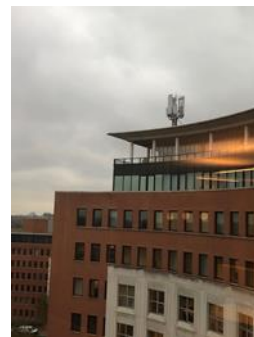
Foto Antenne op daklocatie
