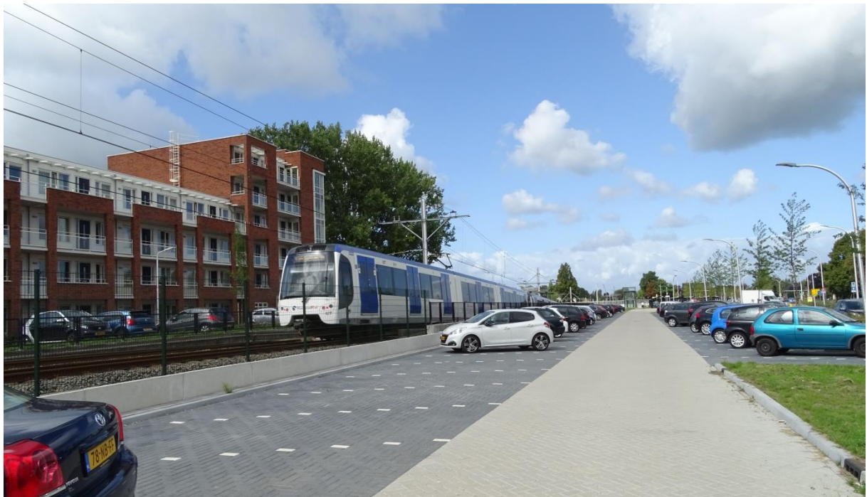
P+R Pijnacker Centrum (fotograaf Serrie Nieuwhoff)
